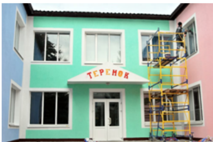
Відремонтований ДНЗ "Теремок" в Новопсковській ОТГ Луганської області
