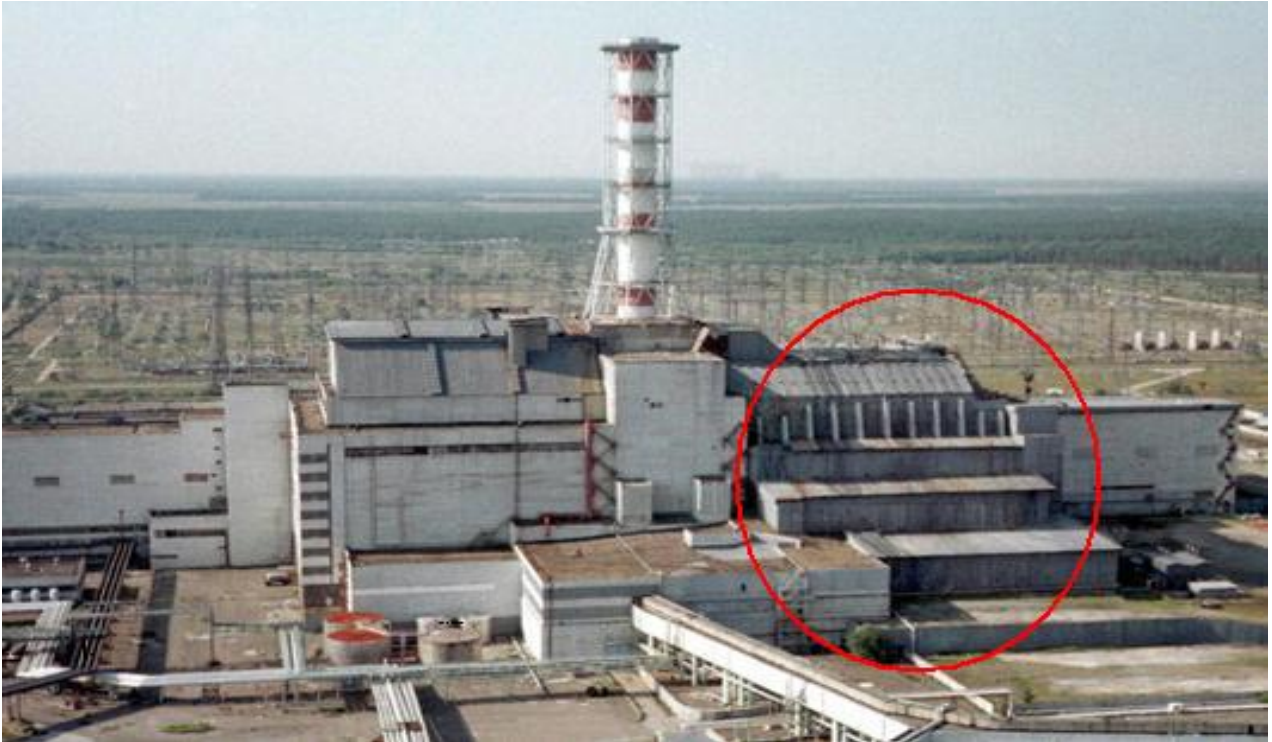
Рис. 1. Об'єкт "Укриття", збудований у 1986 році над зруйнованим 4-м енергоблоком Чорнобильської АЕС (фото ДСП ЧАЕС)
