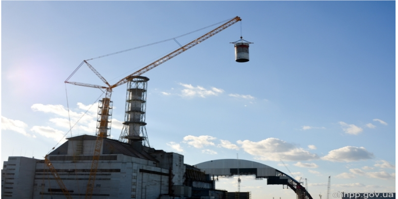
Рис. 3. Нова вентиляційна труба та демонтаж існуючої вентиляційної труби 2-ї черги ЧАЕС (фото ДСП ЧАЕС)
