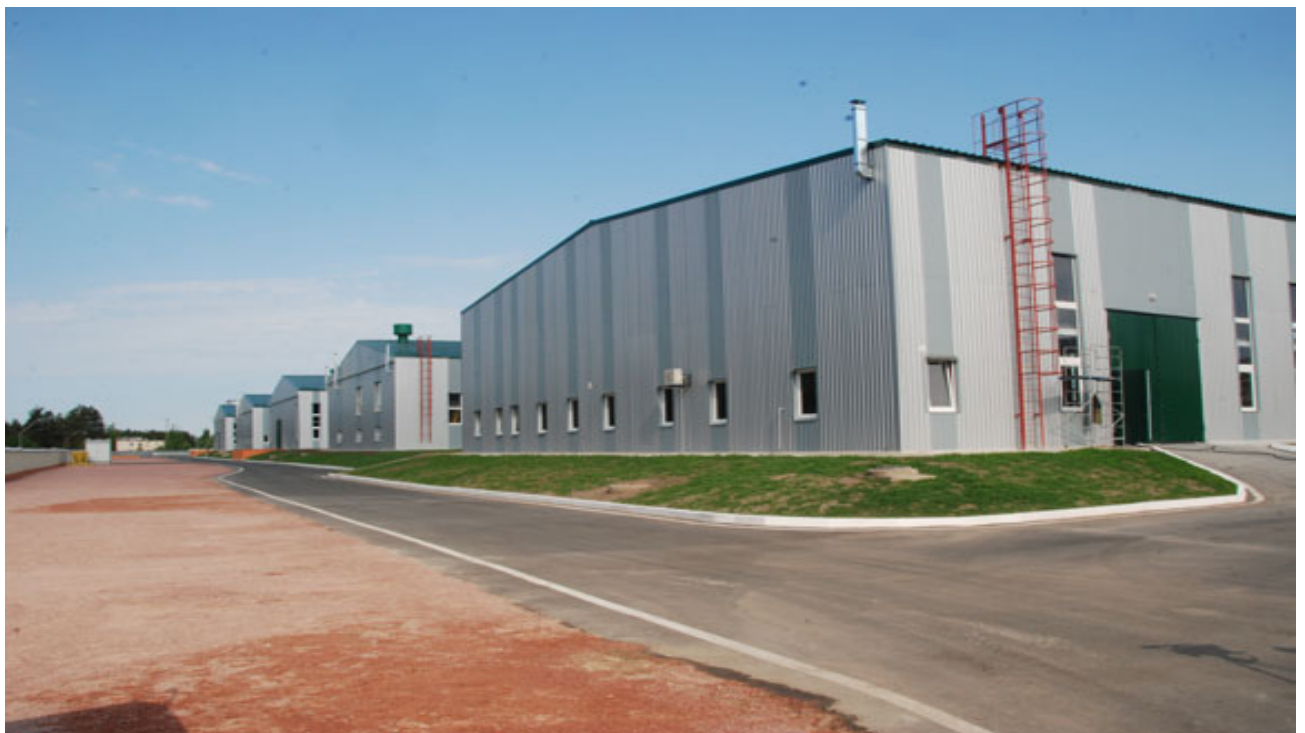
Рис. 6. Комплекс з виробництва металевих бочок і залізобетонних контейнерів для зберігання радіоактивних відходів (м. Славутич Київської області) (фото ДСП ЧАЕС)
