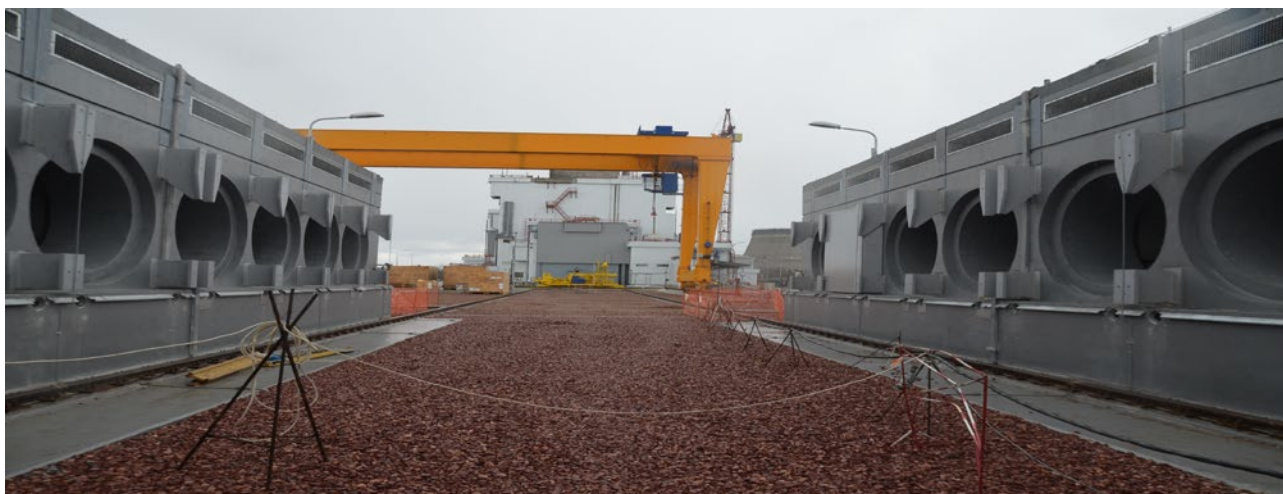
Рис. 10. Проміжне сховище відпрацьованого ядерного палива "сухого" типу (СВЯП-2) (у центрі – установка для підготовки відпрацьованого палива до зберігання, ліворуч і праворуч – елементи зони зберігання відпрацьованого палива) (фото ДСП ЧАЕС)
