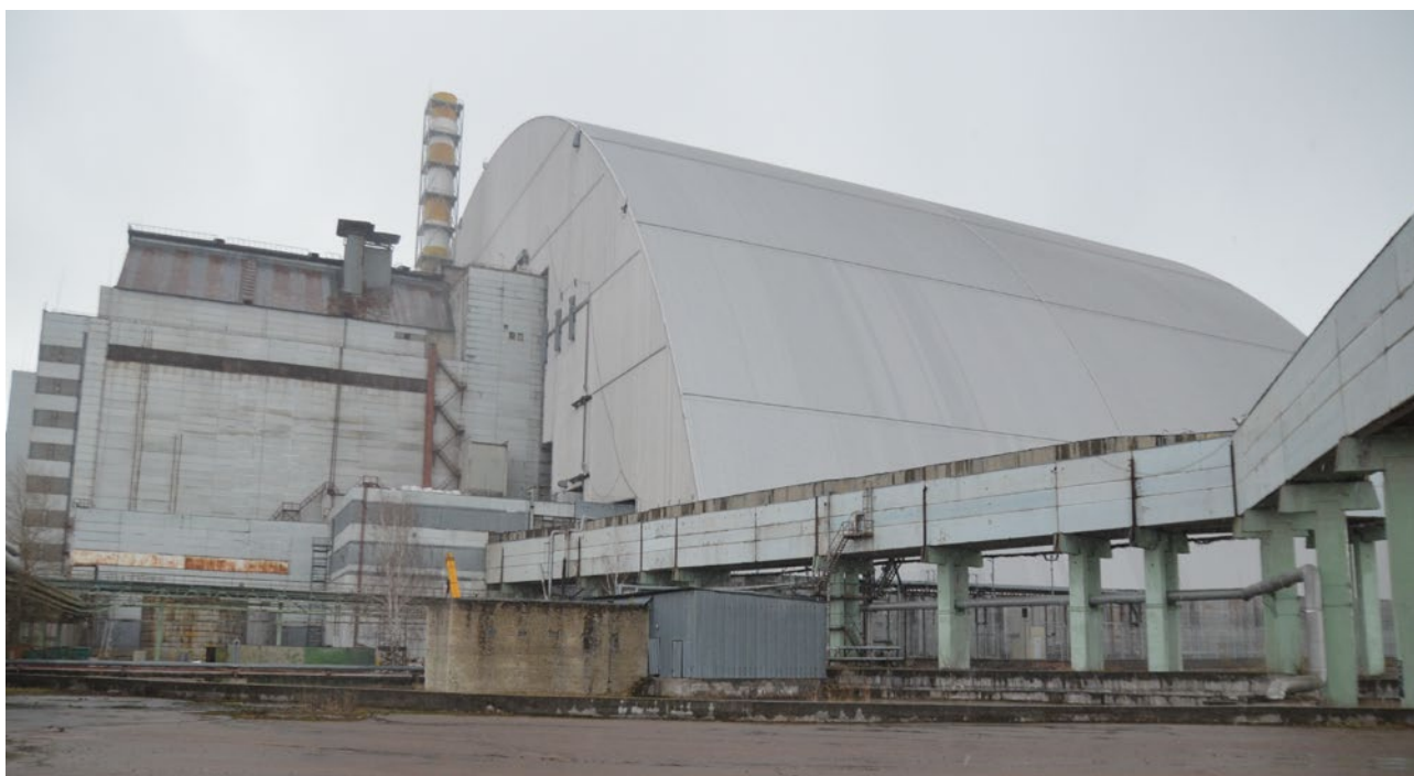
Рис. 4. Новий безпечний конфайнмент, встановлений у проектне положення (фото ДСП ЧАЕС)
