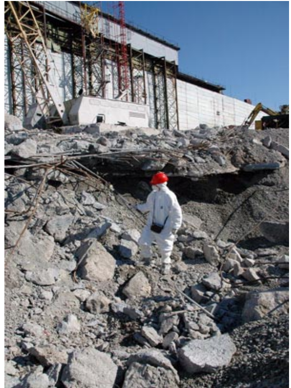
Рис. 2. Видалення "Берми піонерної стіни" (фото ДСП ЧАЕС)
