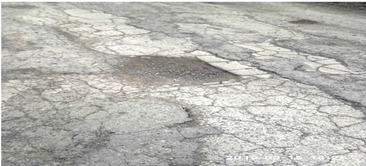
Дата обстеження – 15.03.2019 . Сітка тріщин, вибоїни.
