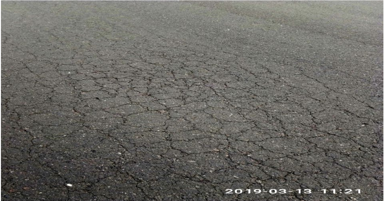
Дата обстеження – 13.03.2019 . Сітка тріщин.
