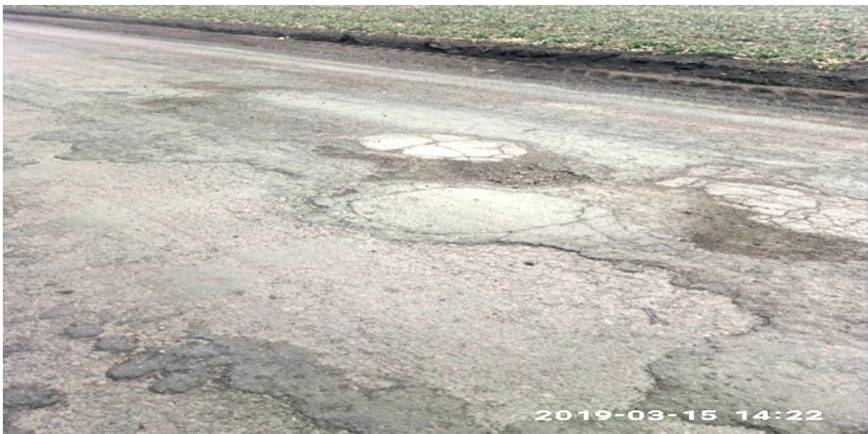
Дата обстеження – 15.03.2019 . Відсутність вирівнюючого шару.
