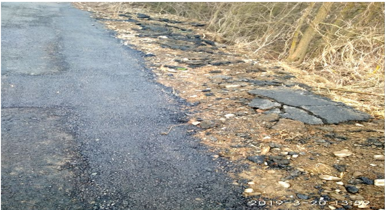
Дата обстеження – 20.03.2019 . Наслідки усунення руйнування кромки.
