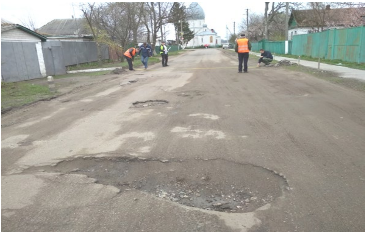
Дата обстеження – 13.04.2019 . Стан дороги між відремонтованими ділянками.
