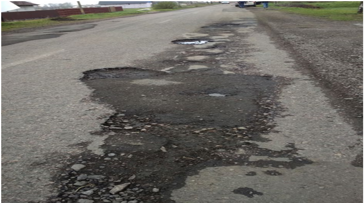
Дата обстеження – 13.04.2019 . Стан дороги після закінчення карти ремонту.
