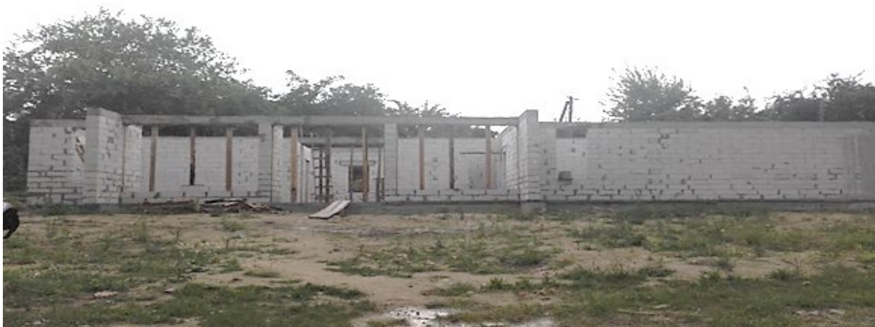
Фото 11. Загальний вигляд будівництва
