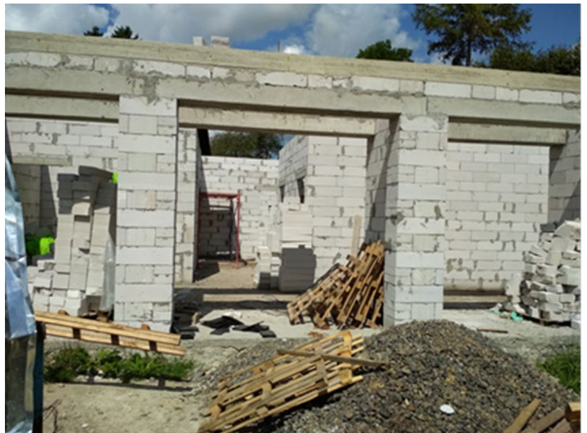
Фото 50. Будівля без даху, перекриття та оздоблення
