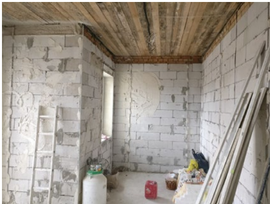
Фото 32. Стан внутрішнього оздоблення
