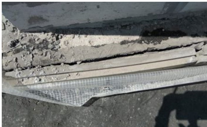
Фото 85. Відшарування плит утеплення і гідроізоляції
