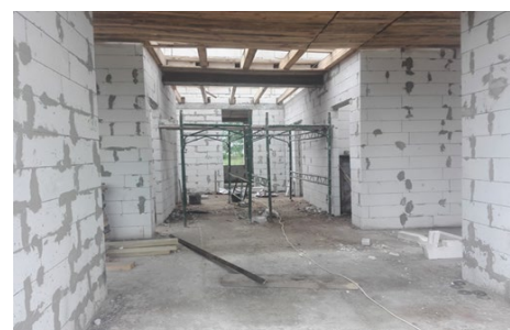
Фото 10. Стан внутрішнього оздоблення
