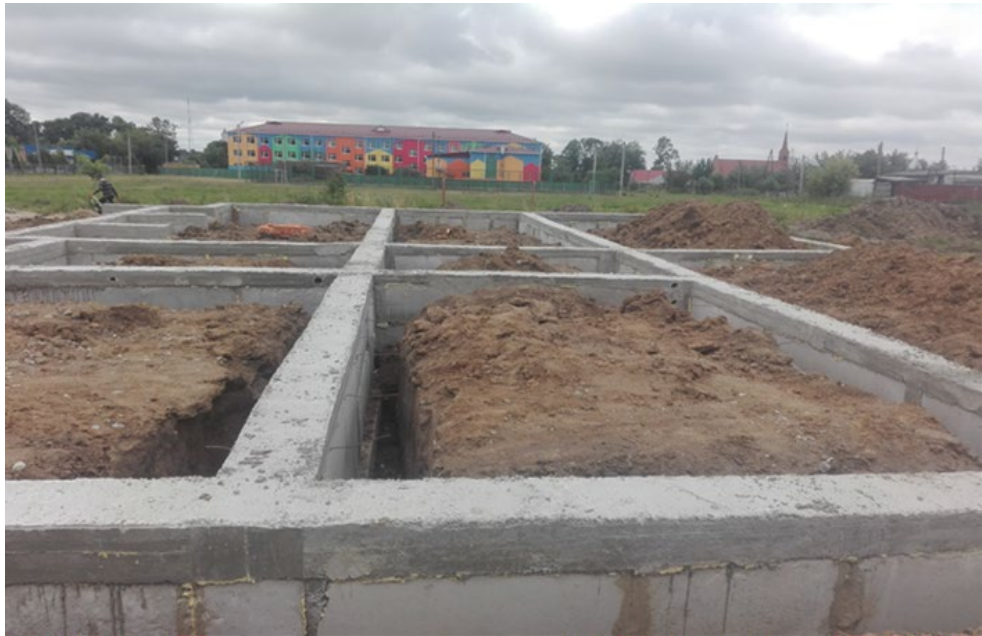
Фото 1. Укладено стрічковий фундамент
