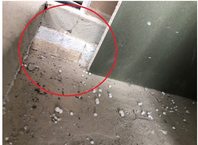
Фото 27. Наявність у шарі підлоги пінопласту замість екструдованого піностиролу
