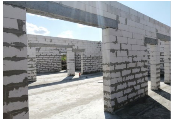
Фото 80. Не виконано армопоясу
