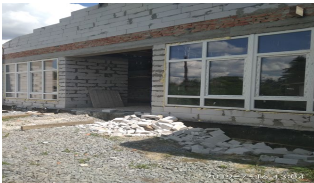
Фото 13. Фасад амбулаторії, що будується
