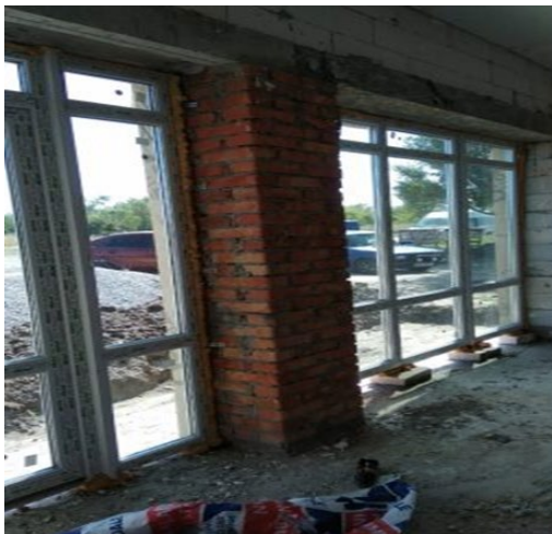
Фото 77. Стан внутрішнього оздоблення
