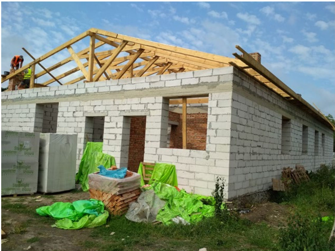
Фото 53. Улаштування дерев'яного каркасу даху об'єкта будівництва
