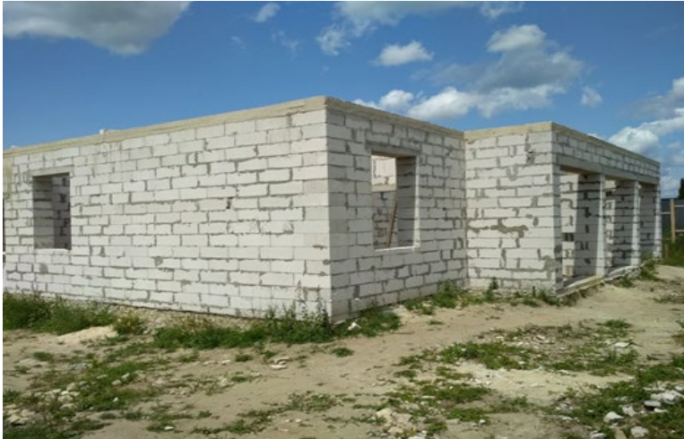
Фото 51. Об'єкт будівництва без даху і перекриття
