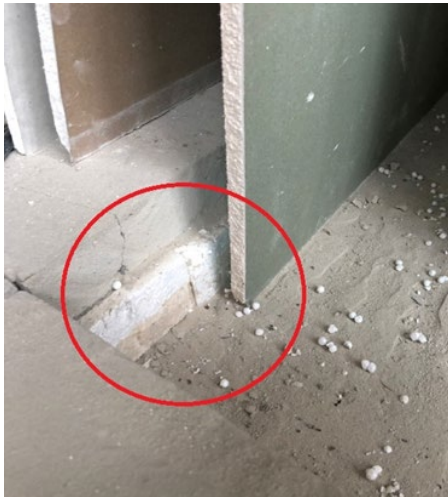
Фото 27. Наявність у шарі підлоги пінопласту замість екструдованого піностиролу
