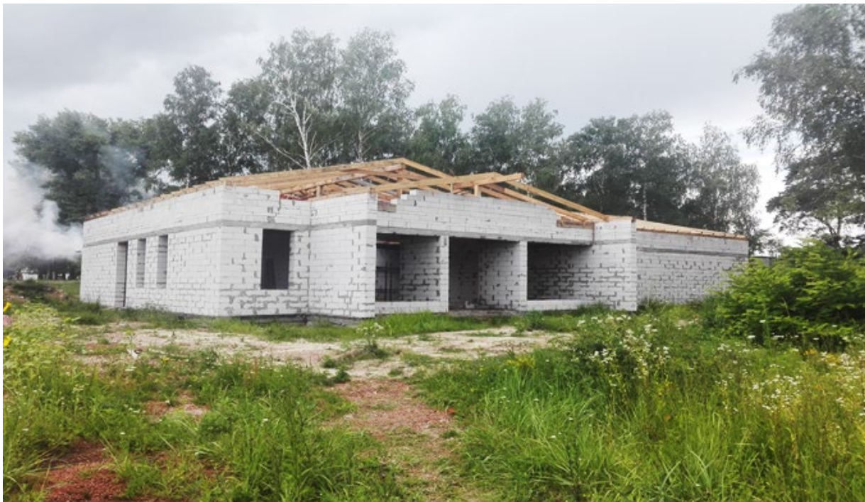
Фото 9. Загальний вигляд амбулаторії
