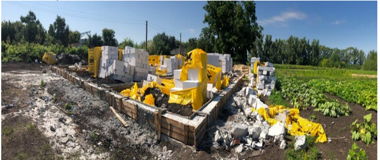
Фото 18. Загальний вигляд будівництва
