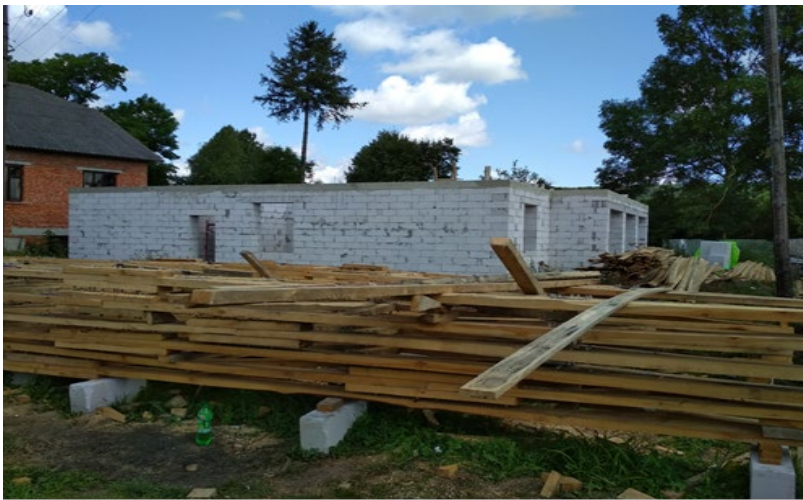
Фото 49. Піломатеріали для даху і перекриття
