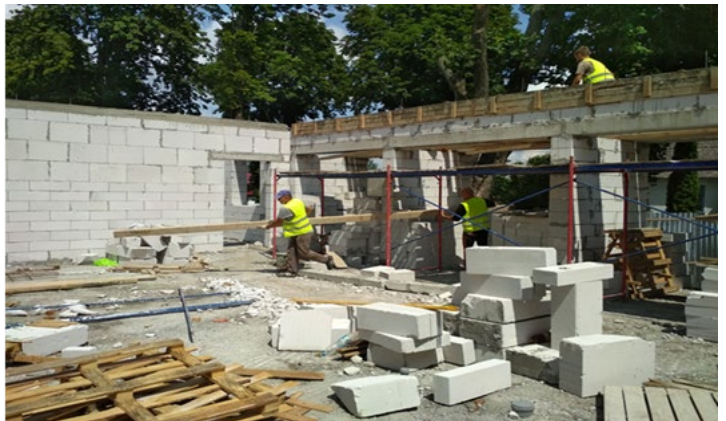
Фото 52. Улаштування зовнішніх стін
