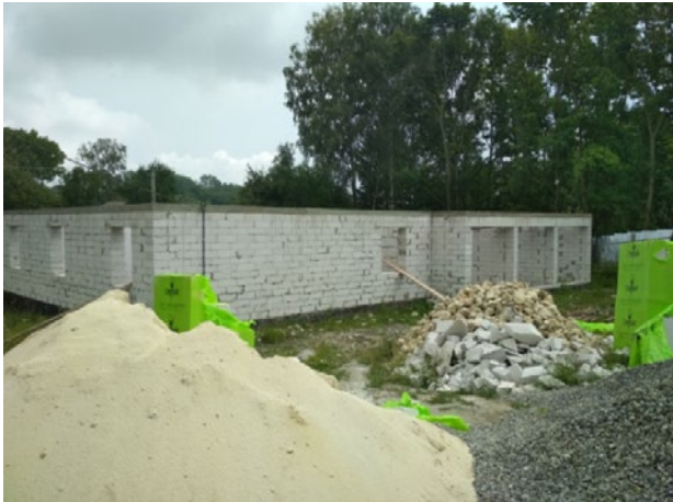
Фото 59. Об'єкт без даху, перекриття і оздоблення
