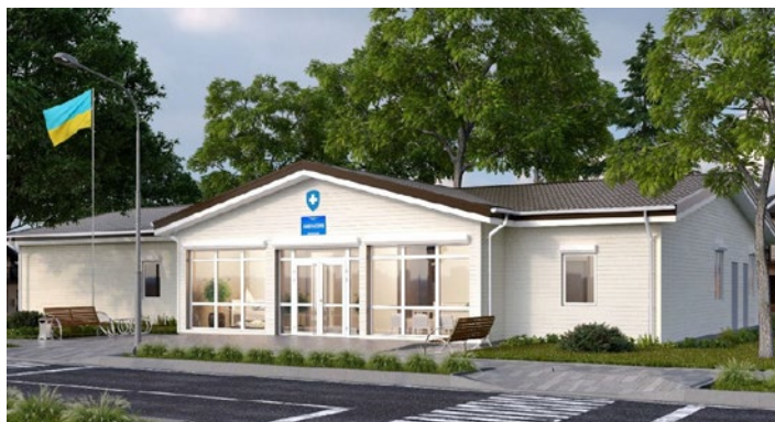
Приклад фасаду будівлі амбулаторії ПМД у сільській місцевості
