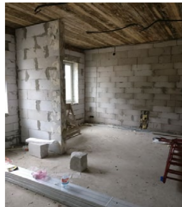
Фото 33. Цвіль на перекритті
