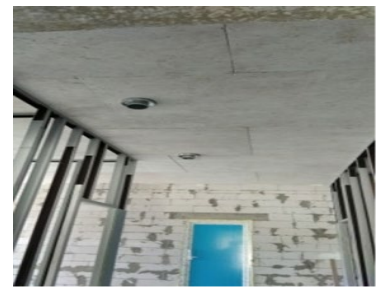
Фото 75. Каркас перегородки
