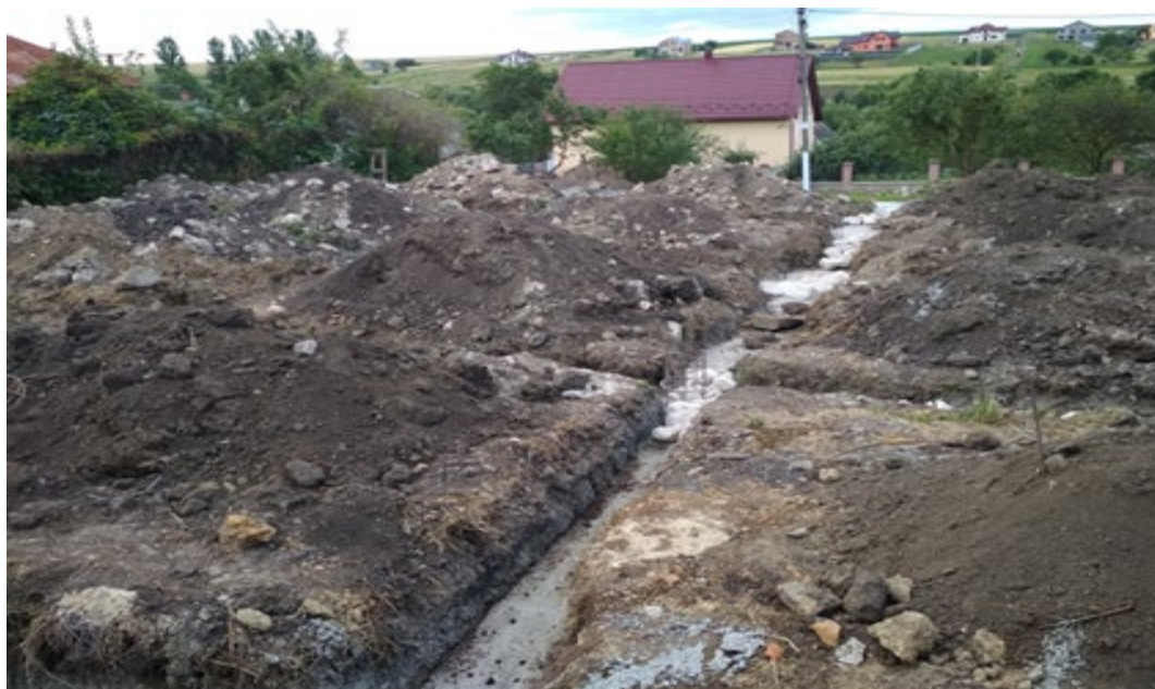
Фото 54. Бетонування фундаменту
