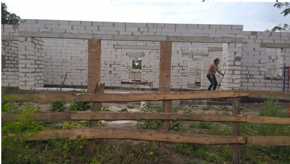
Фото 61. Об'єкт будівництва без армпоясу, перекриття і даху
