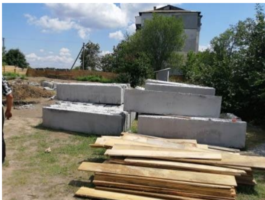
Фото 70. Фундаментні блоки й опалубка
