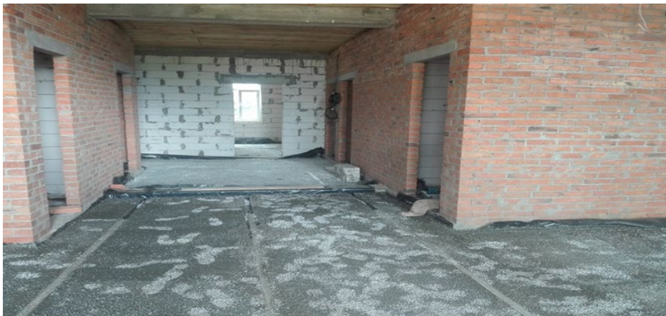
Фото 6. Стан внутрішнього оздоблення нової амбулаторії (відсутні внутрішні опоряджувальні роботи)
