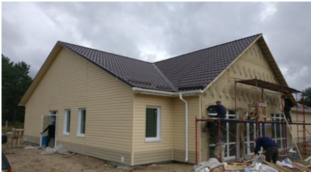
Фото 31. Виконання фасадних робіт
