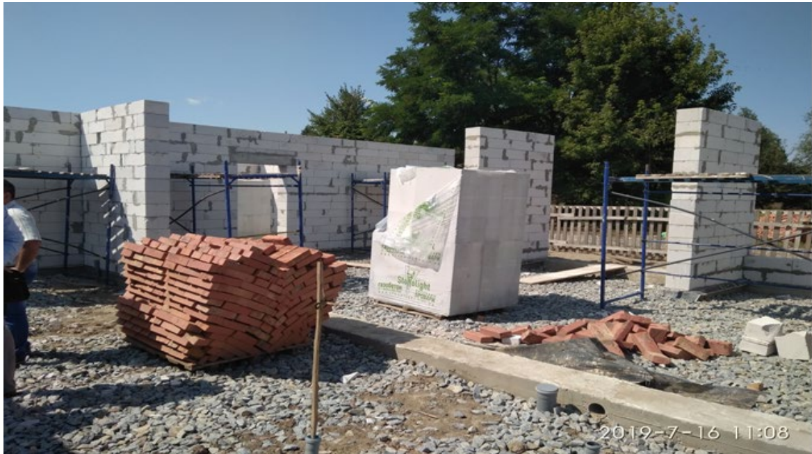
Фото 7. Будівництво нової амбулаторії
