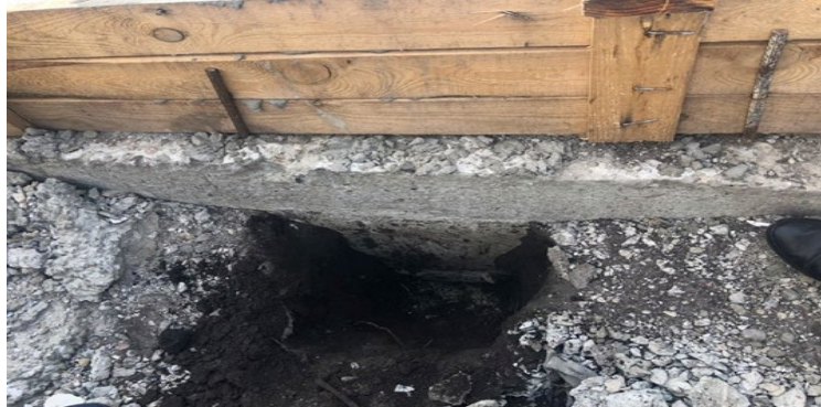
Фото 21. Відсутня гідроізоляція на блоках ФБС
