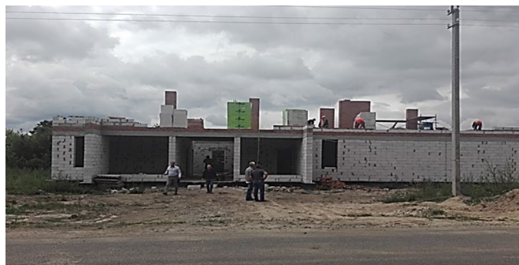
Фото 14. Загальний вигляд будівництва
