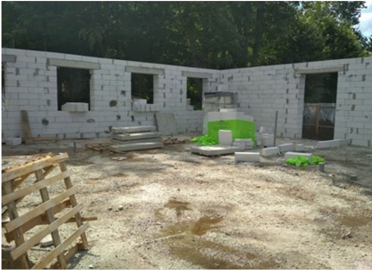
Фото 47. Зведення зовнішніх стін
