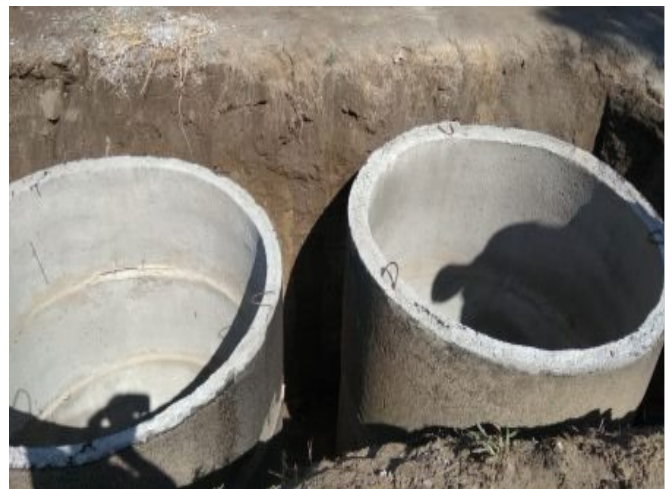
Фото 78. Стан готовності протипожежного резервуара
