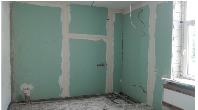
Фото 3. Вирівнювання гіпсокартоном внутрішніх стін
