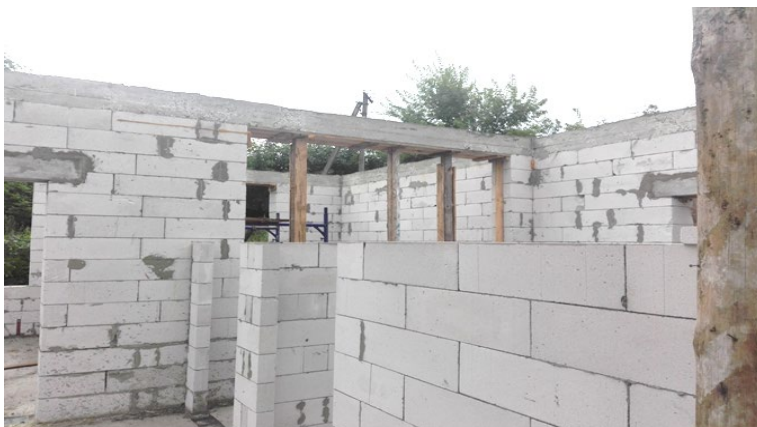
Фото 12. Недобудовані внутрішні перегородки
