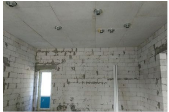
Фото 73. Стан оздоблення стін
