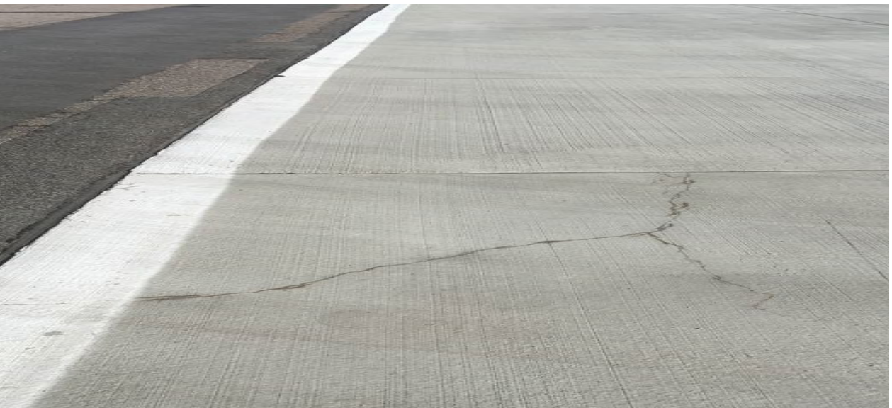
Фото 10. Стан бетонного покриття рульових доріжок аеропорту "Херсон" після реконструкції (тріщини довжиною 5–10 метрів)
