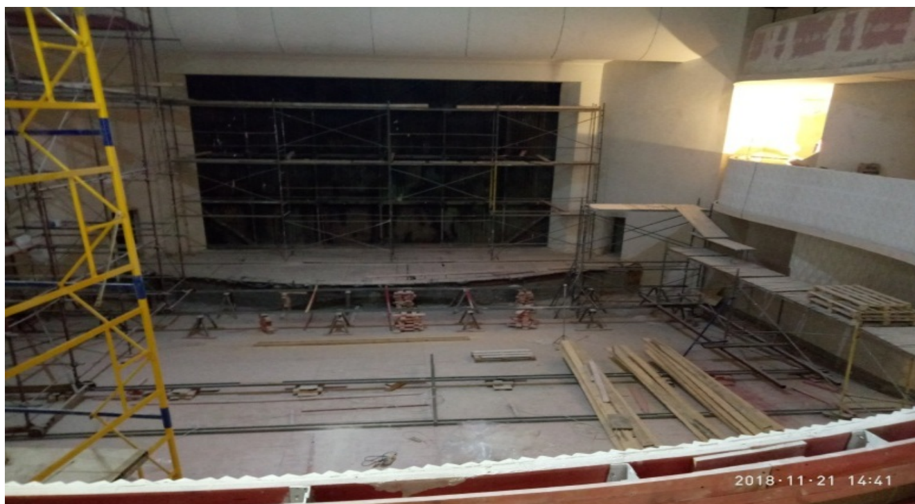
Фото 2. Вигляд глядацької зали драмтеатру в м. Черкаси, що засвідчує відсутність монтажу світильників та улаштування килимового покриття
