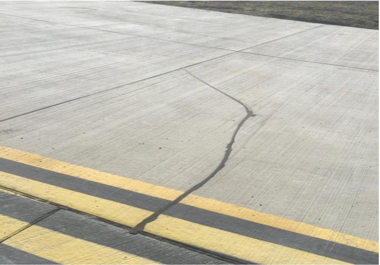
Фото 9. Стан бетонного покриття рульових доріжок аеропорту "Херсон" після реконструкції (тріщини довжиною 5–10 метрів), лютий 2019 р.
