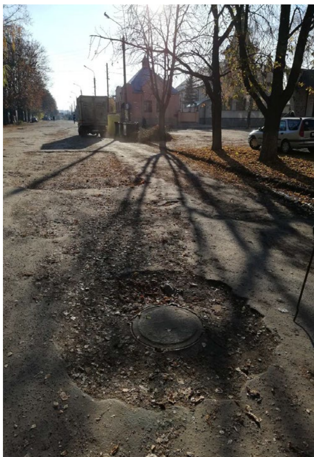
Фото 6. Стан міського колектора у м. Суми після реконструкції. Колодязь колектора без ходових скоб. 01.11.2018
