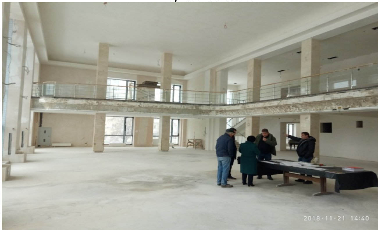
Фото 1. Вигляд фойє драмтеатру в м. Черкаси станом на 21.11.2018, що засвідчує відсутність монтажу світильників
