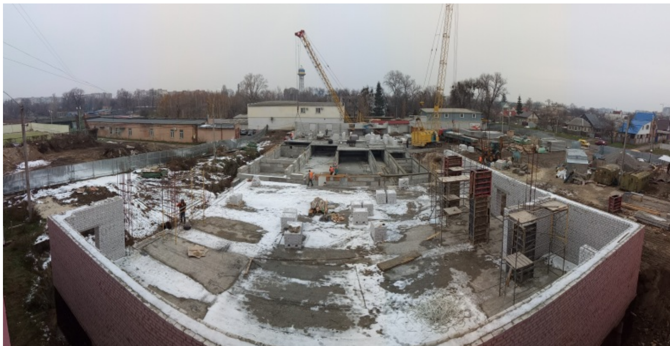
Фото 3. Стан виконання робіт на об'єкті "Реконструкція адмінбудівлі ДЮСШ олімпійського резерву" станом на 19.11.2018, м. Черкаси
