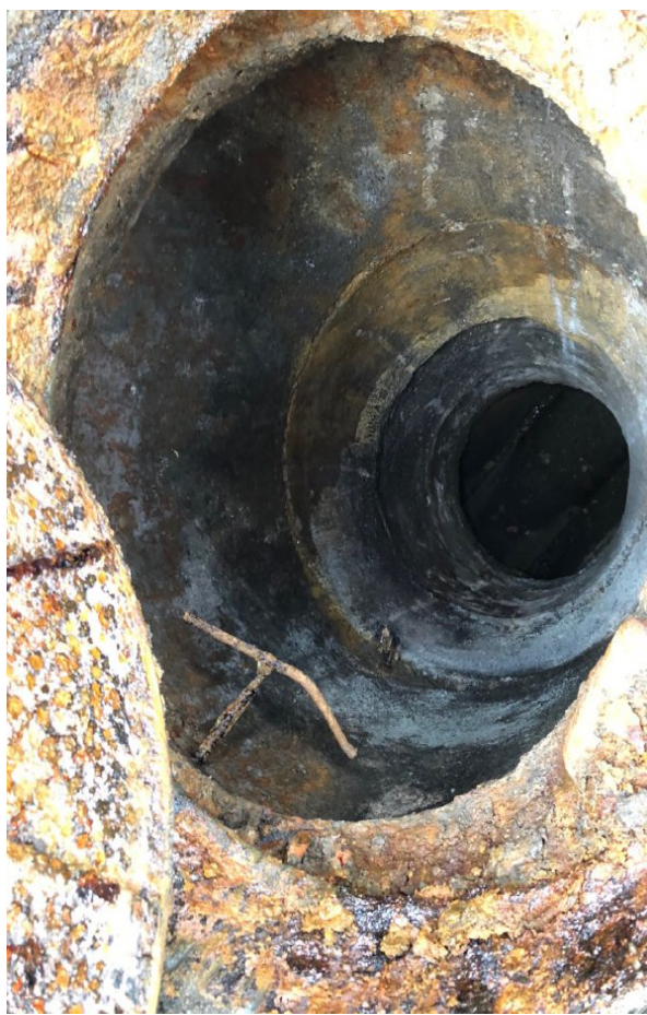
Фото 6. Стан міського колектора у м. Суми після реконструкції. Колодязь колектора без ходових скоб. 01.11.2018
