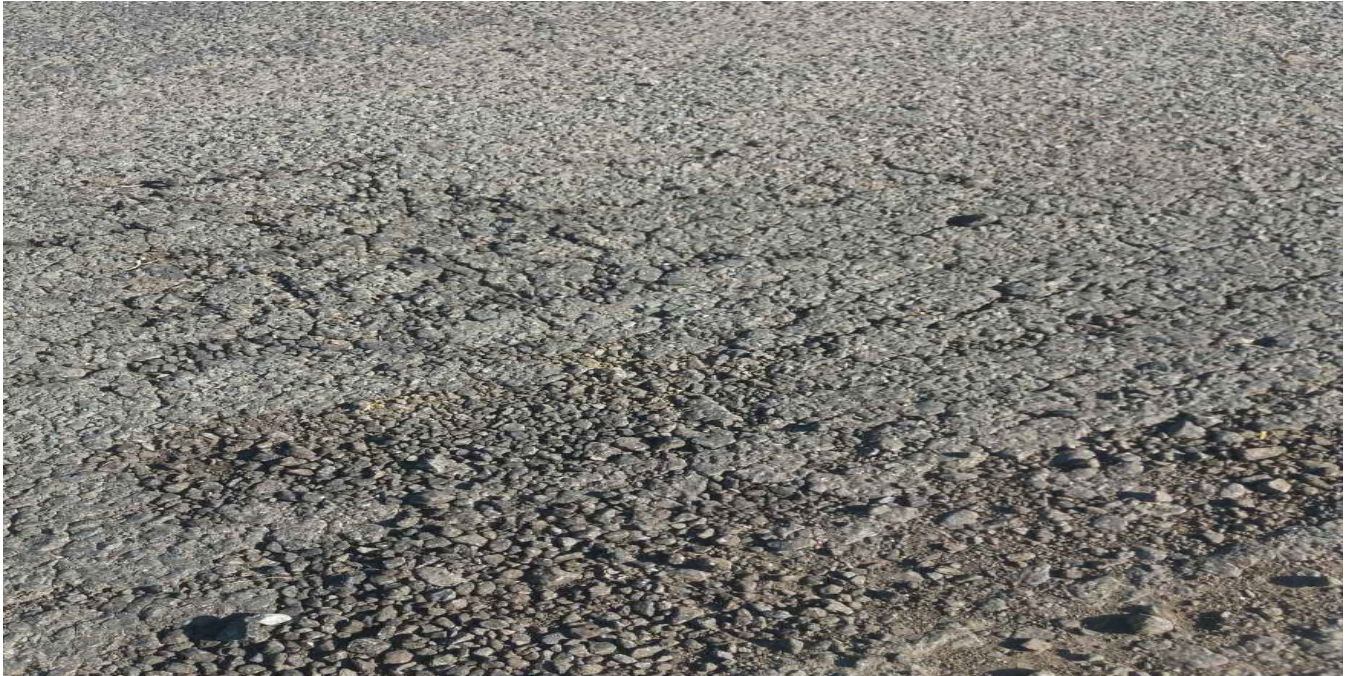
Фото 14. Фрагмент автодороги С162102 "Саврань – Кам'яне – кордон Кіровоградської області" з тріщинами і викришуванням поверхневого покриття станом на листопад 2018 року (після поточного середнього ремонту, виконаного у 2017 році, товщиною покриття 6 см)
