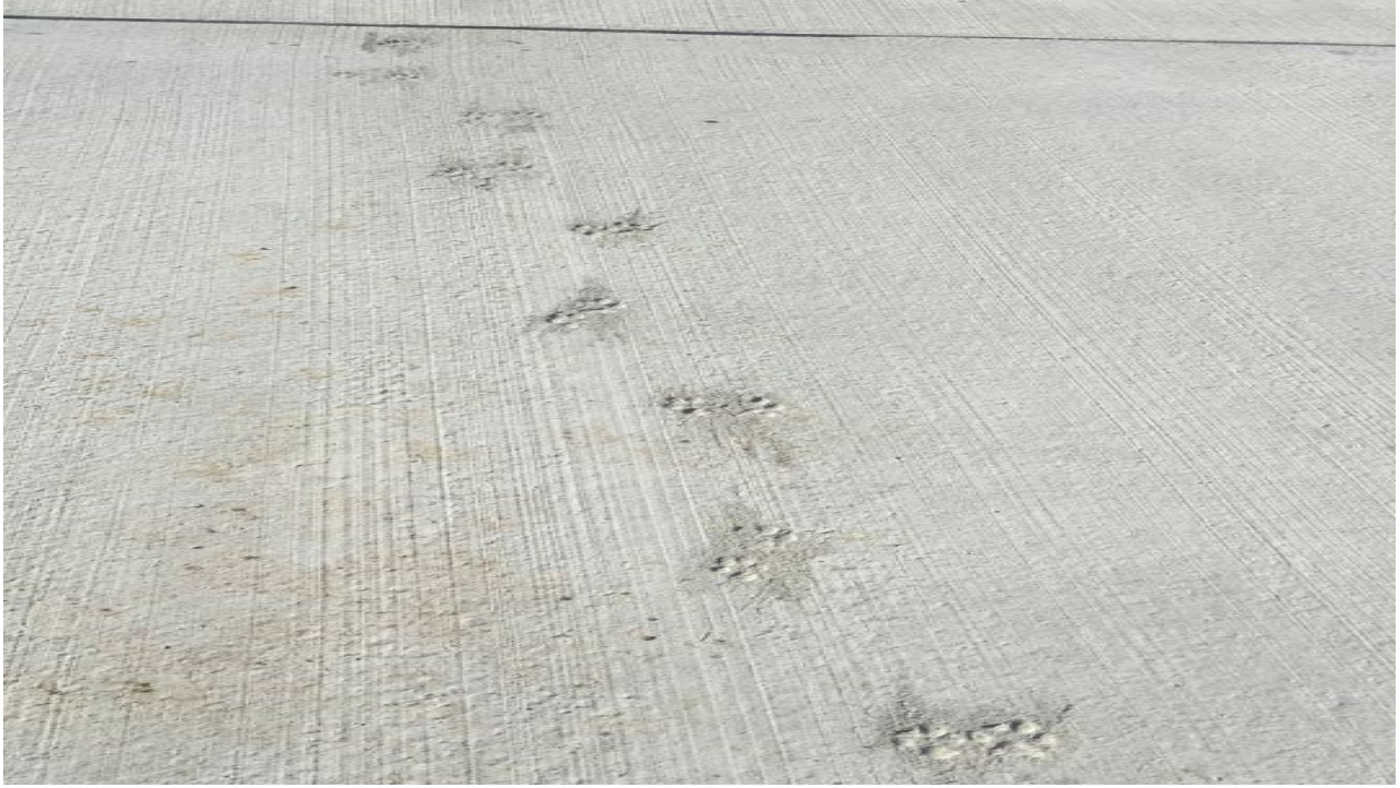
Фото 11. Стан бетонного покриття рульових доріжок аеропорту "Херсон" після реконструкції (відбитки кінцівок живих істот)
