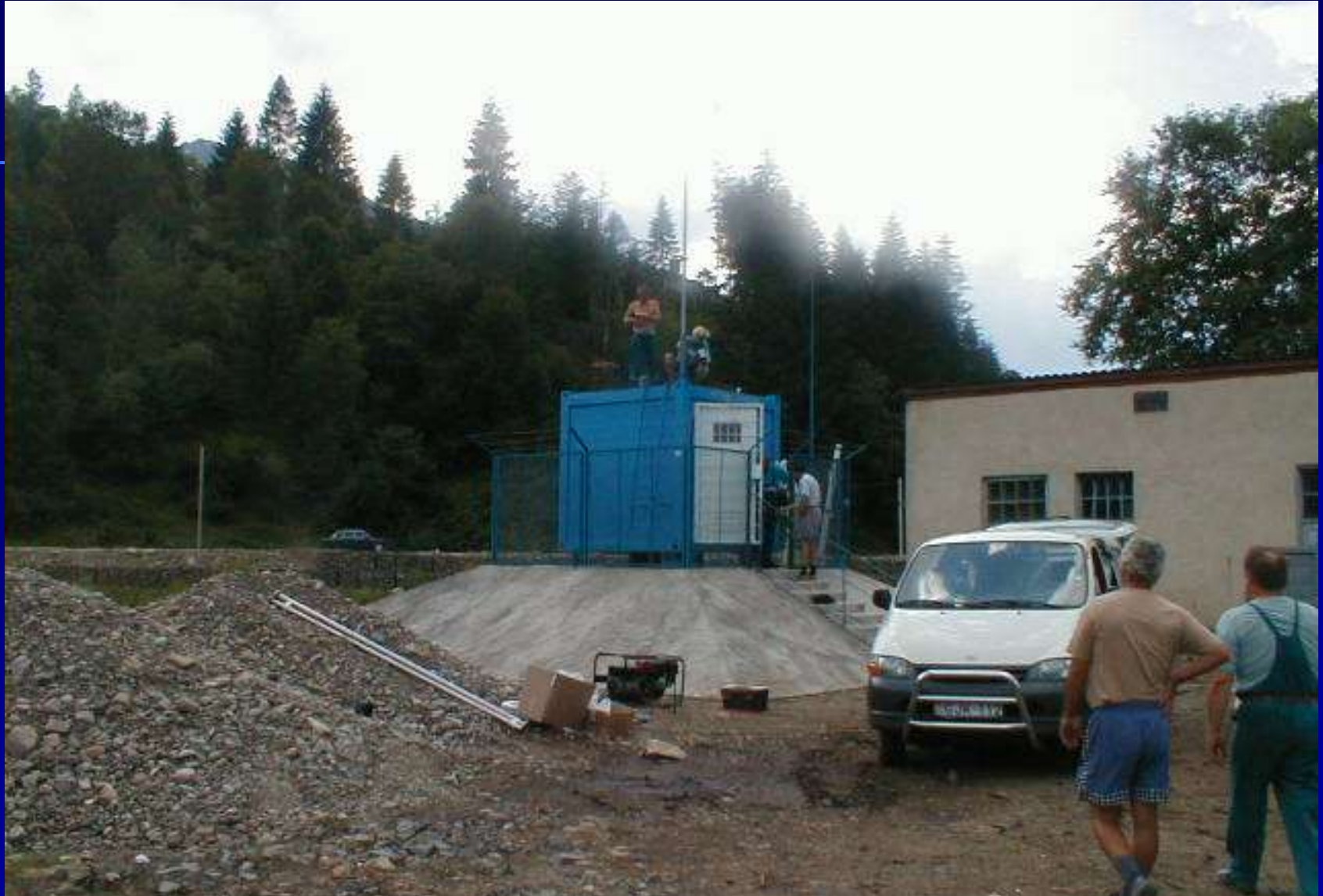
Монтаж автоматизованої вимірювальної станції на р. Тересва, смт. Усть-Чорна, 2003 р.
