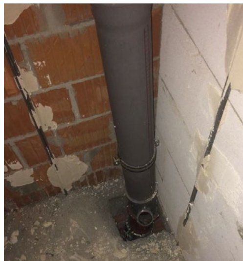
Фото 2. Стан виконання оздоблювальних робіт у квартирах, на які придбано майнові права
