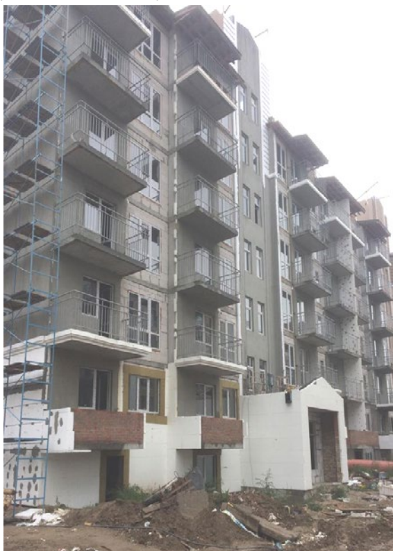
Фото 1. Житловий будинок за адресою: м. Київ, вул. Метрологічна, 26, станом на 24.09.2018
