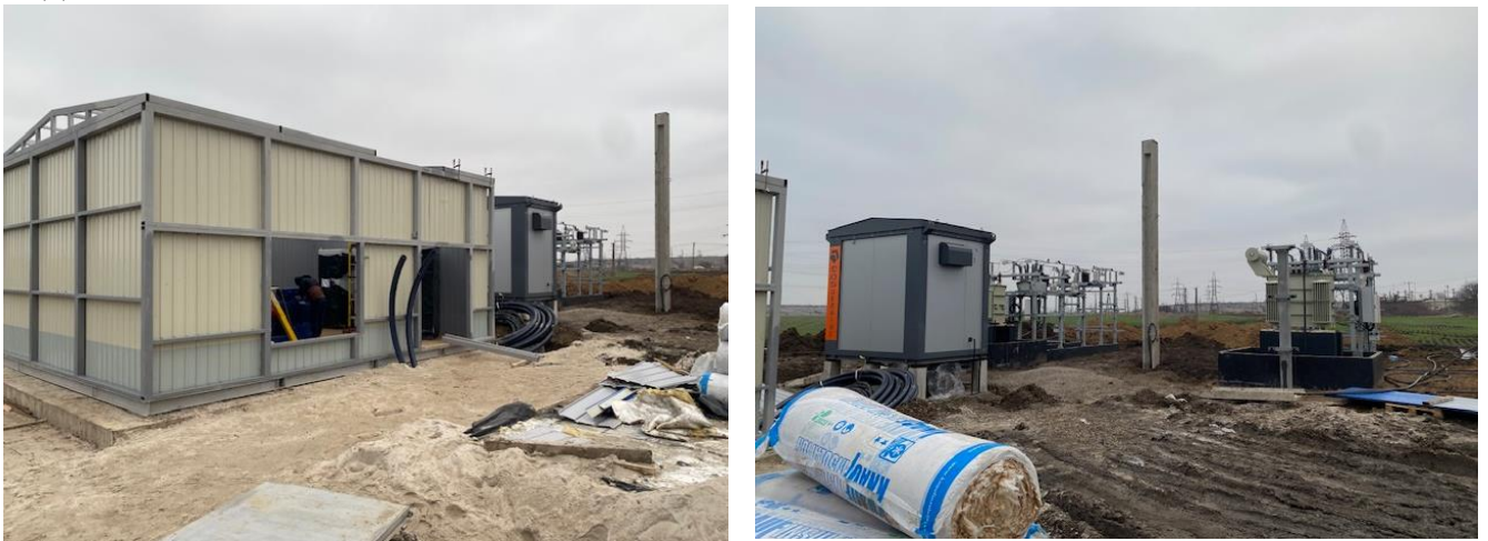
Фото 2. Водонасосна станція № 2, здійснюється монтаж обладнання магістрального водогону Марганець – Нікополь – Покров (16 лютого 2024 року)
