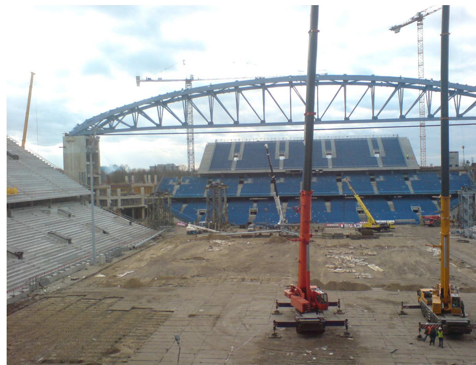
Zaawansowanie rozbudowy i modernizacji stadionu w listopadzie 2009 r.
