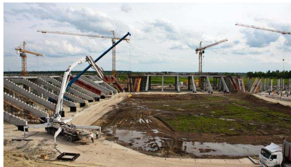
Стан будівництва стадіону
