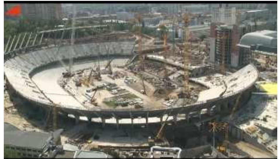
Стан будівництва стадіону
