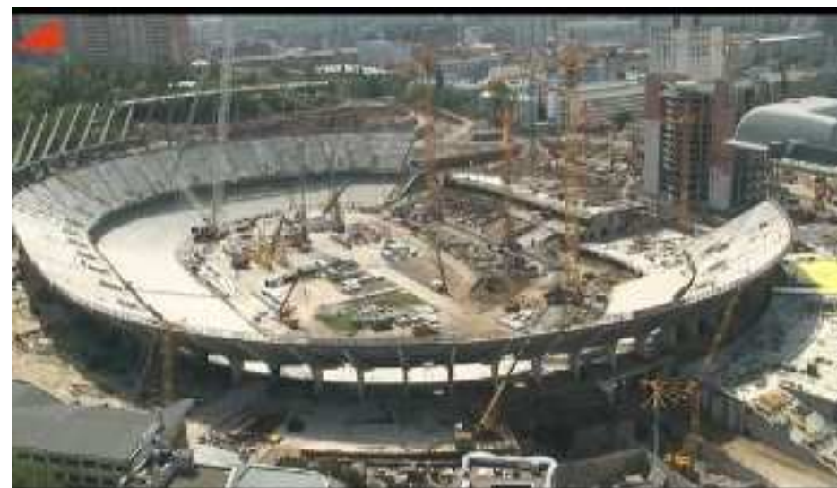
Stan prac w trakcie kontroli
