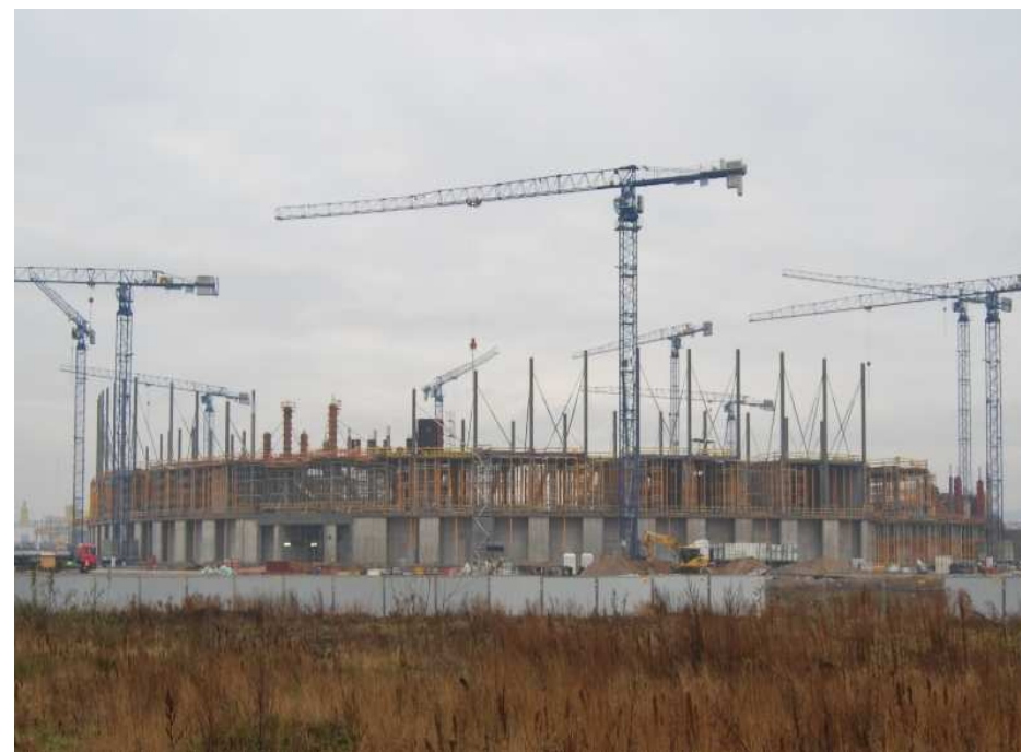
Stan zaawansowania budowy stadionu w grudniu 2009 r.
