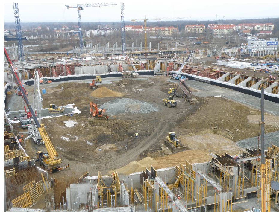
Stan zaawansowania budowy stadionu w grudniu 2009 r.
