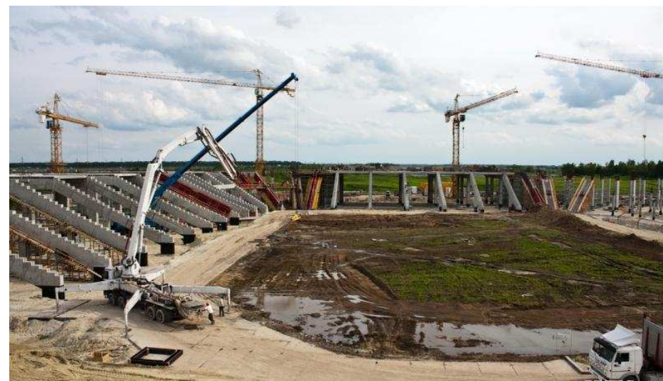
Stan prac w trakcie kontroli
